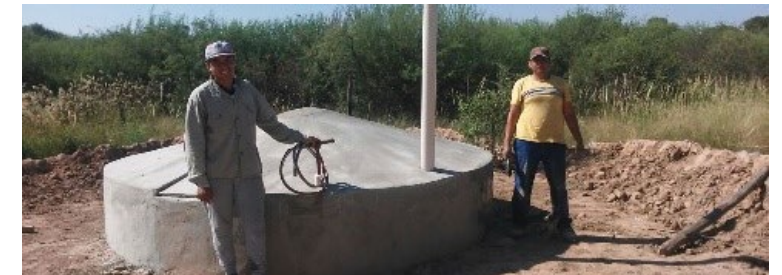
Prácticas ecoamigables para mitigar el riesgo de inundaciones
