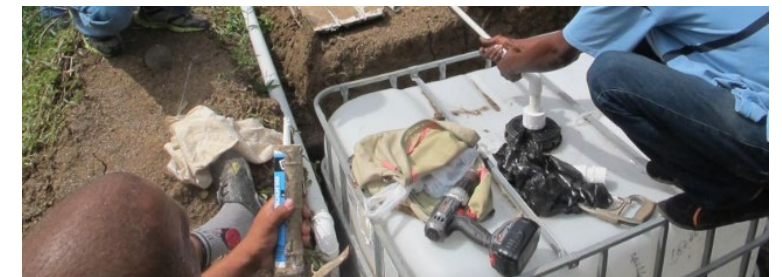
Sistema de recolección de agua lluvia para reúso
